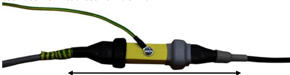
Рисунок 3. Установка защитных колпачков. Слева – фиксация изолянтной, справа – осажена термотрубка. Длина в собранном состоянии 150-155 мм.
